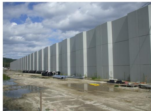
新設された防潮堤(海拔9.7m)(山田町)
