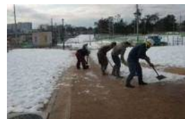
園路除雪作業 （東伏見公園）
