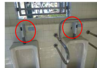
トイレの臭気改善や清潔トイレ改修の要望により水洗センサーの設置 (武蔵野公園)
