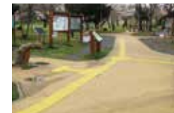
点字ブロック
